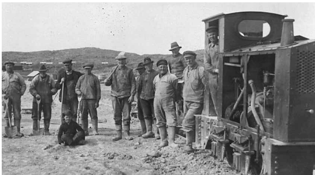
En samling av de män som byggde Sote kanal. Till sin hjälp hade de ett lokomotiv och en mindre järnbana.
