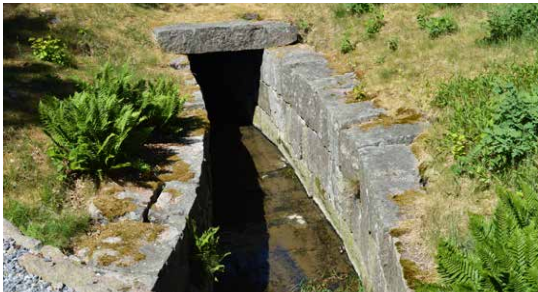
Vrångstads underjordiska kanal är ett av Sotens mest märkvärdiga och solitära kanalprojekt.
