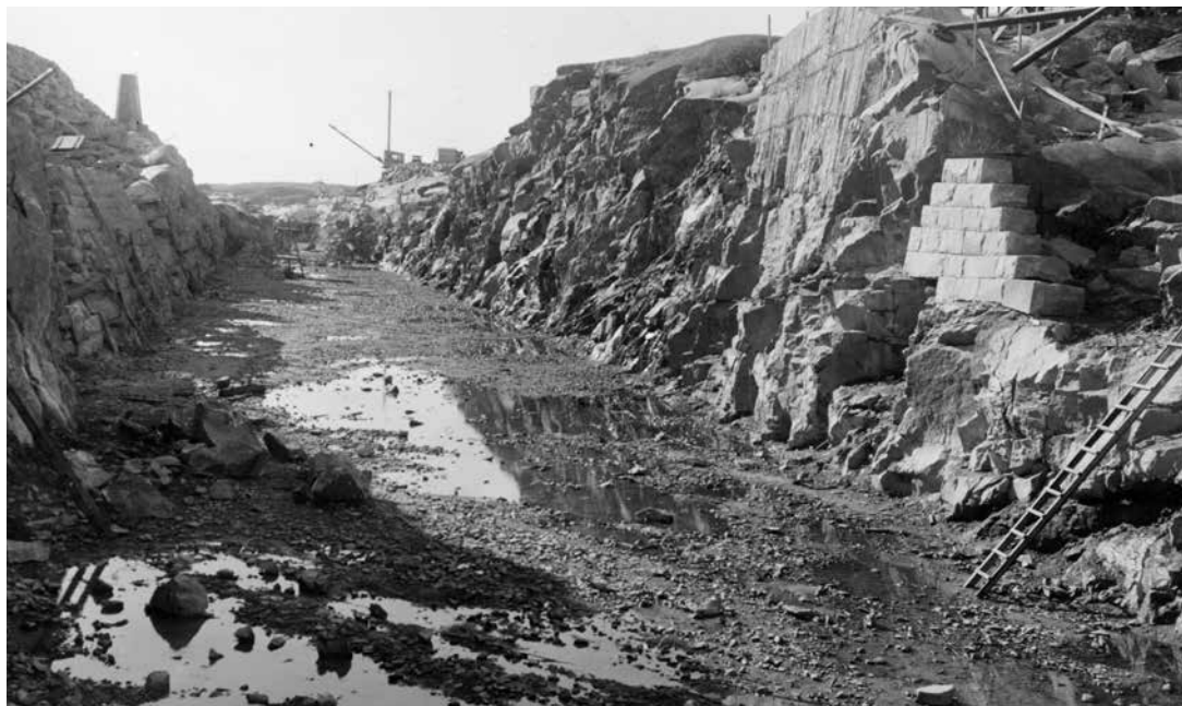
Fotografiet visar med all tydlighet vilken arbetsinsats som krävdes när arbetarna sprängde sig ned i berget utan alltför avancerade hjälpmedel.
